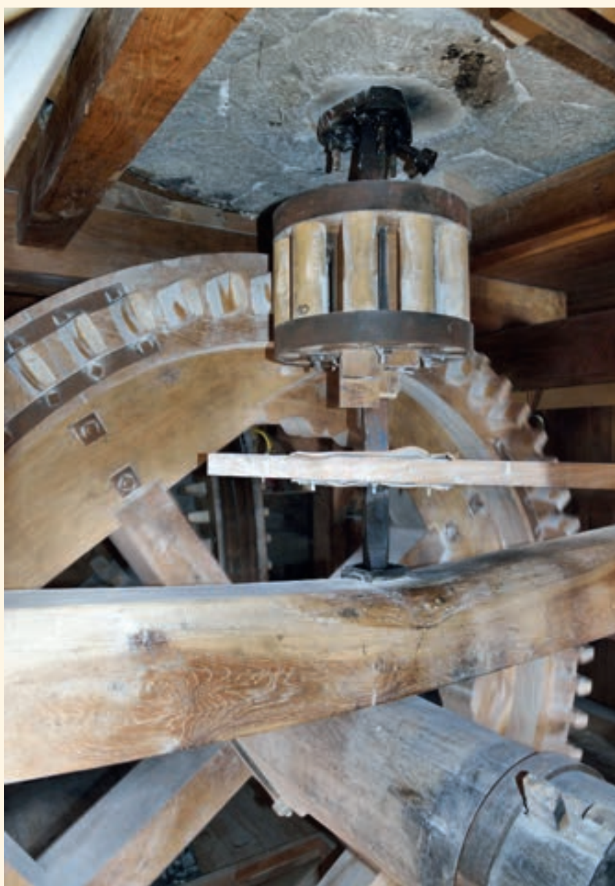
Interieurfoto van de gereconstrueerde schipmolen in Minden (D), waarop de aandrijving van de molenstenen te zien is. Zo moeten de molenstenen in Meinerswijk ook aangedreven zijn geweest (foto Rasbak, 28 maart 2015).
